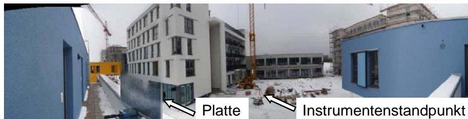
Abb. 3: Panoramabild der Baustelle mit Platte und Instrumentenstandpunkt
