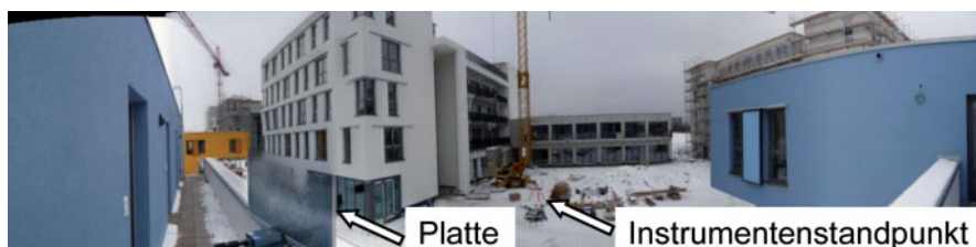
Abb. 3: Panoramabild der Baustelle mit Platte und Instrumentenstandpunkt
